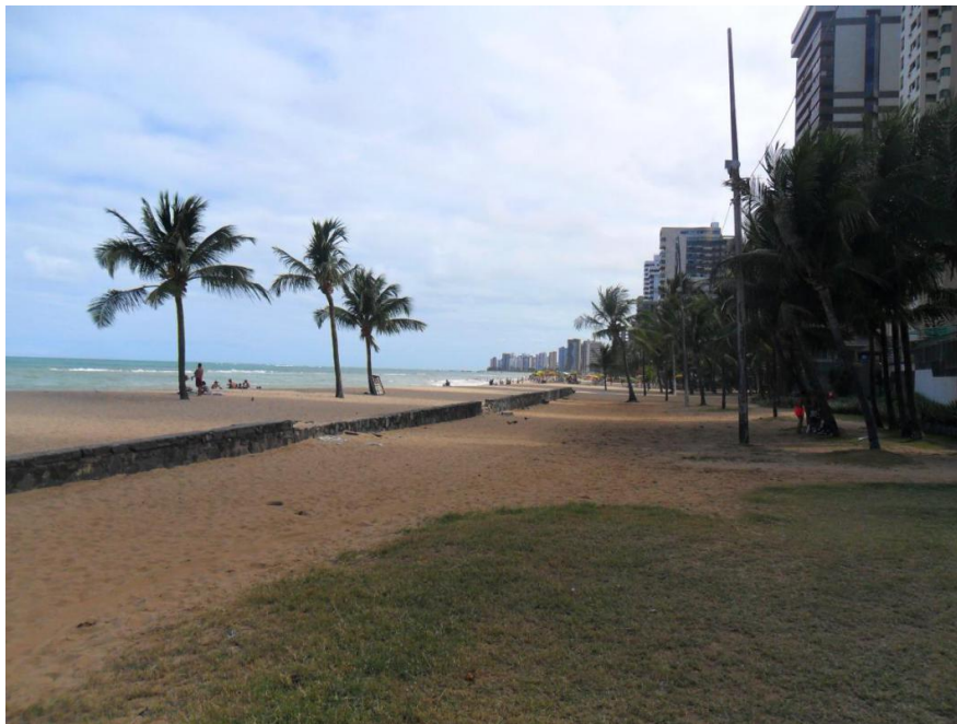
Figura 03: Muro de contenção existente, próximo ao retorno da Av. Beira Mar de Piedade.
