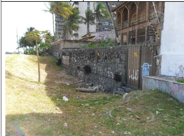
Vista do desnível entre as residências e o solo natural
