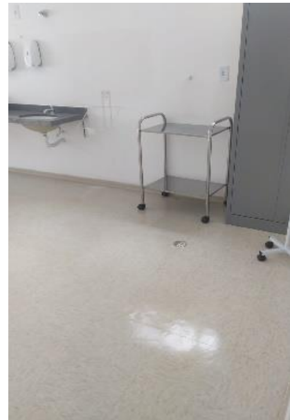
FOTO 23: PPP 03 sem banheira instalada
