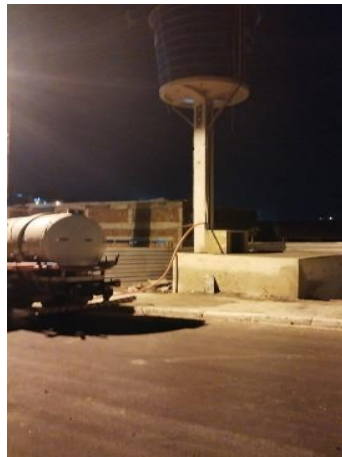
FOTO 4: Abastecimento às 21h no dia 05/04/22 no tanque de água geradores no CPN
