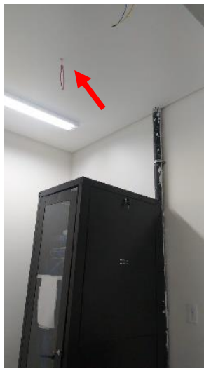
FOTO 10 e 11: Detectores de fumaça não instalados nos
