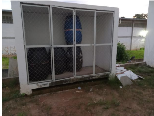
FOTO 26: Estrutura para armazenamento do lixo infectante
