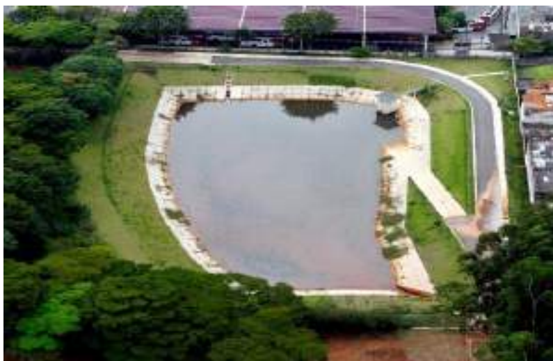
Figura 12 - Reservatório de detenção
