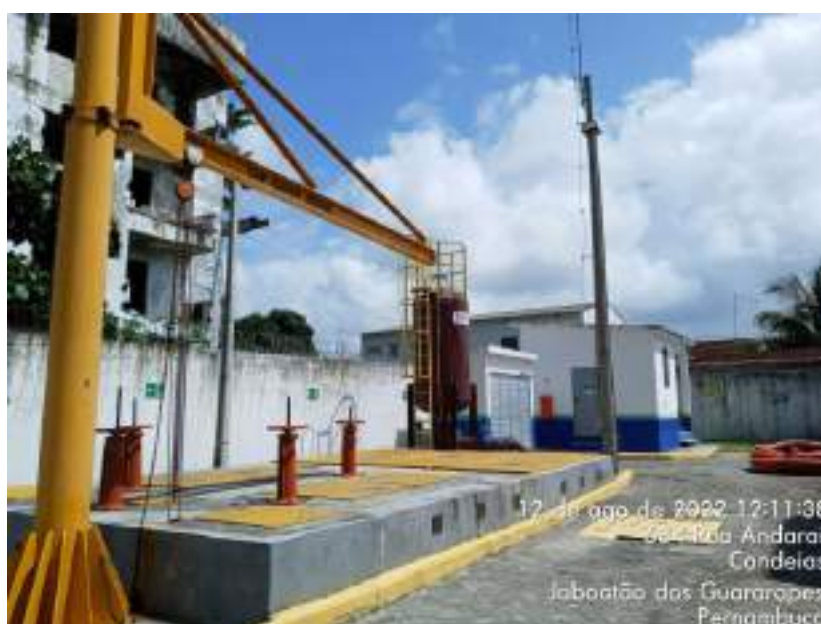
Figura 5 - Estação elevatória de esgoto de Prazeres.
