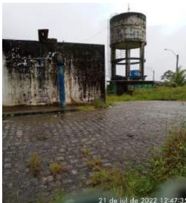
Figura 3 - Reservatório pertencente ao SAA de Jaboatão dos Guararapes.
