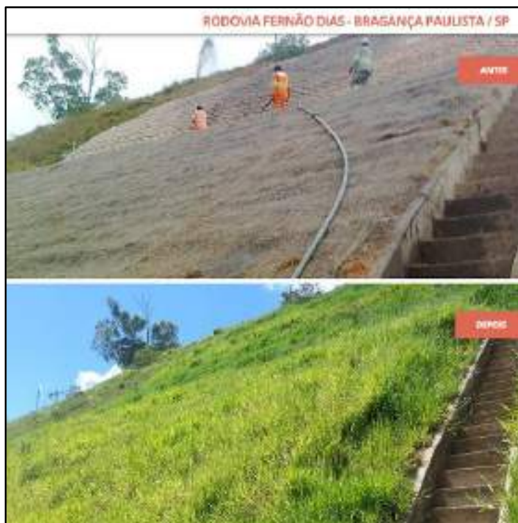
Figura 31 - Comparação antes e depois da aplicação da hidrossemeadura
