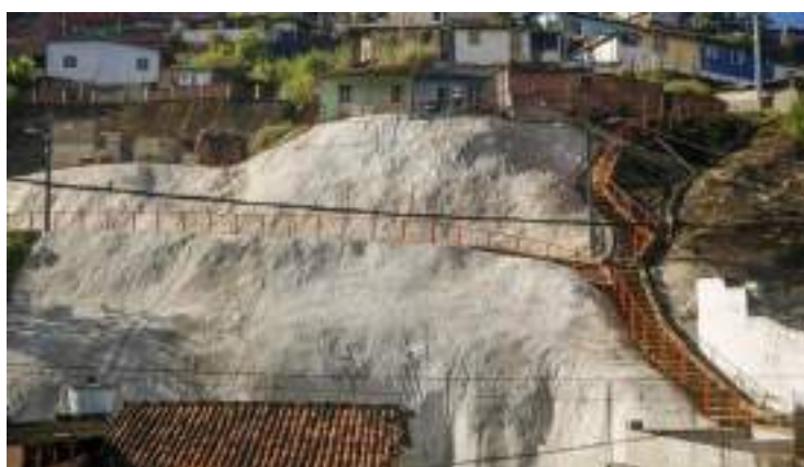
Figura 28 - Aplicação de geomanta com calda de cimento em Recife
