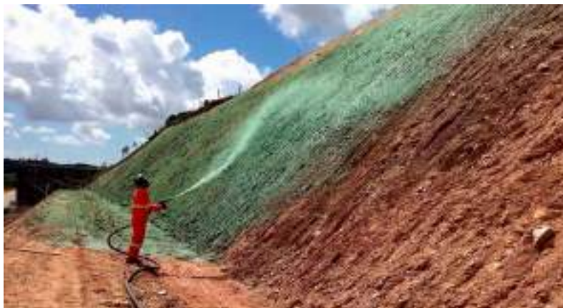
Figura 30 - Aplicação da técnica de hidrossemeadura sobre um talude
