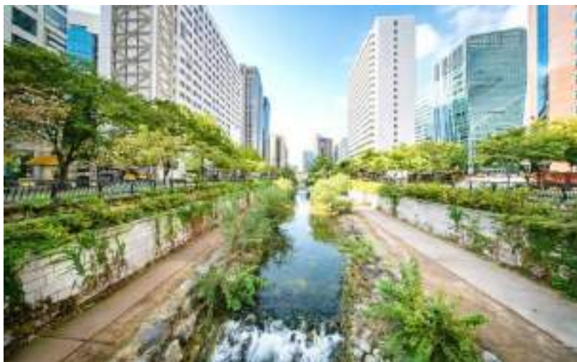
Figura 21 - Implantação bem sucedida de um sistema sustentável de drenagem
