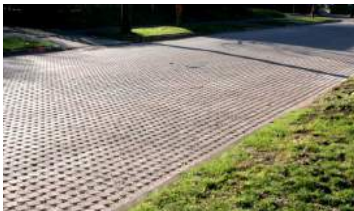
Figura 16 - Pavimentos permeáveis implantados em uma rua
